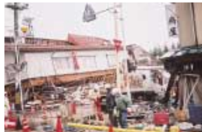
新潟県川口町。倒壊したスーパー。 今年11月には建て替え、新オープンしました。
