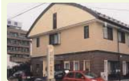
グループホーム全景。ホームにはエレベーターが設置されています。
